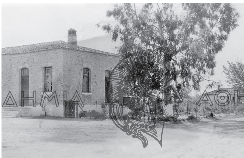
4. Δημοτικόν Σχολεῖον Αμμουδιάς Β.Δ. όψις.
